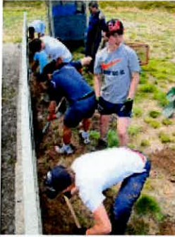
Nordic Centre Trench Dig 3-1.jpeg 43K
